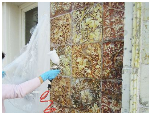
Figura 6: Fase di trattamento con pistola aerografo delle ceramiche di rivestimento dell'Hotel Hungaria a Venezia Lido.
