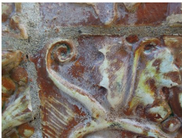
Figura 2: Residui di polimeri organici utilizzati per il trattamento di materiale ceramico esposto in ambiente esterno.
