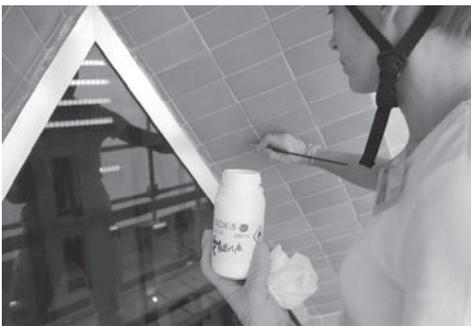
*Fig. 7. Ritocco con formulato sol-gel applicato a pennello, eseguito su piastrelle interessate da micro perforazioni dello smalto*
